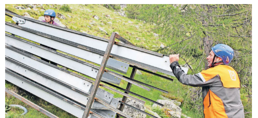
Teamarbeit. Jeder Griff muss sitzen, ob bei der Verschraubung der Teile über dem Abgrund oder bei der Bereitstellung der Gitterroste.
