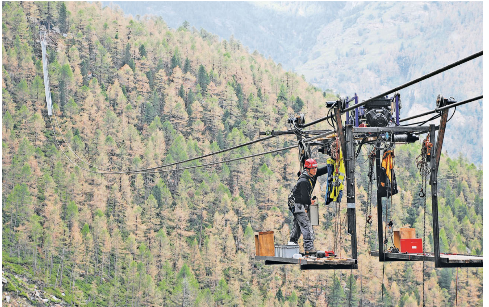
Über den Baumwipfeln. Eine vom Erbauer eigens für diese Brücke konstruierte Schwebevorrichtung lässt die 3 m langen und 60 kg schweren, verzinkten Gitterroste an den Tragseilen dorthin führen, wo sie zum Boden der Hängebrücke zusammenschraubt werden.
