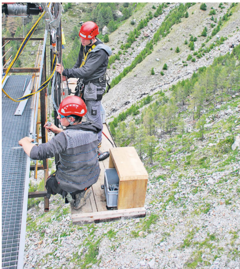
Nur für Schwindelfreie. Der Arbeitsplatz der Hängebrücken-Monteur 85 m über dem «Grabengufel».
