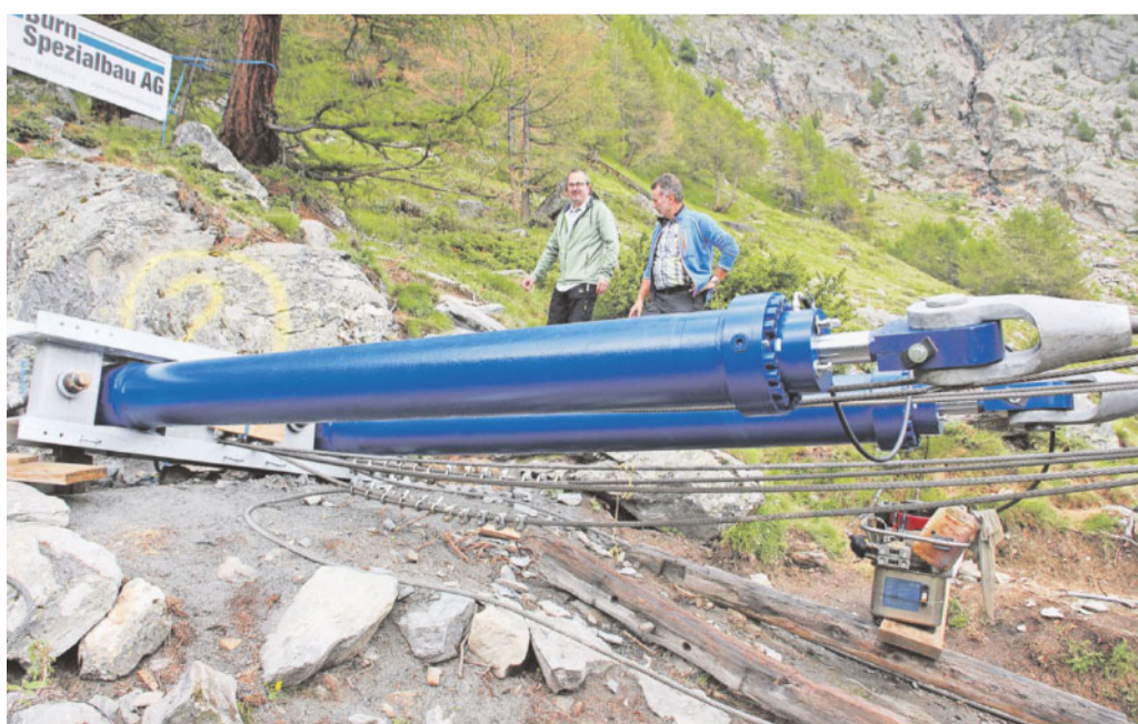
Gewaltig. Hydraulikzylinder regulieren die Spannung der Tragseile. Dieses System wird bei einer Hängebrücke erstmals angewendet – und von Paul Summermatter und Stefan Truffer bestaunt.
