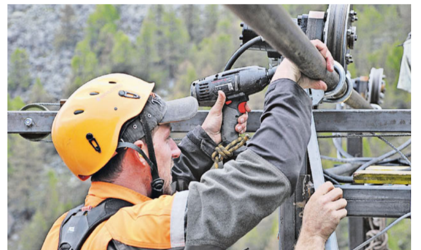
Über den Baumwipfeln. Eine vom Erbauer eigens für diese Brücke konstruierte Schwebevorrichtung lässt die 3 m langen und 60 kg schweren, verzinkten Gitterroste an den Tragseilen dorthin führen, wo sie zum Boden der Hängebrücke zusammenschraubt werden.
