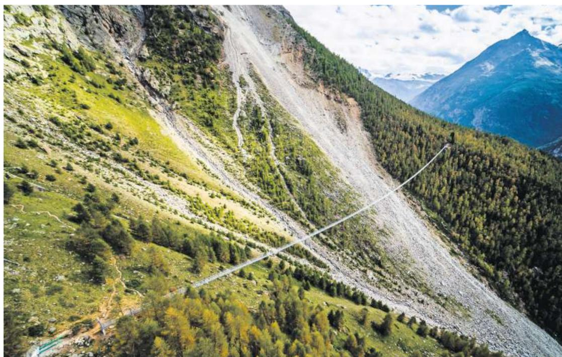
**Küssnacht** Die ATP Hydraulik AG hat für die Hängebrücke zwischen Grächen und Zermatt neuartige Hydraulikzylinder produziert. Sie regulieren die Spannung und verhindern ein allzu heftiges Aufschaukeln der Konstruktion. ATP-Firmengründer Heinrich Schwerzmann hat die 494 Meter lange Brücke überquert. 17 Bild: Keystone
