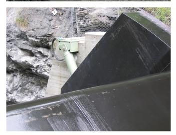
Im Wasserkraftwerk Rabiusa oberhalb von Chur sorgen Hydraulikzylinder der ATP Hydraulik und eine Aggregateinheit im technischen Raum dafür, dass sich Wasser in einem Staubecken sammelt und in die richtigen Schächte gelangt. Der Wasserstand wird so geregelt, dass das Kraftwerk permanent mit Wasser versorgt ist.
