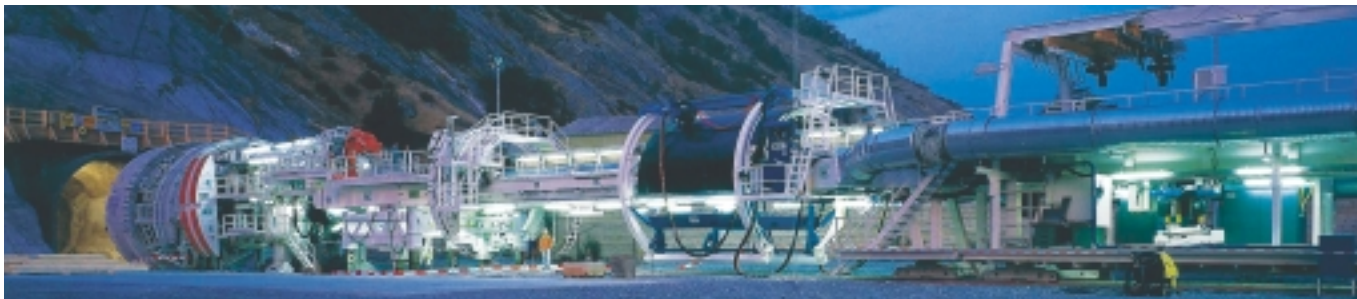
TBM Lötschberg Basistunnel
