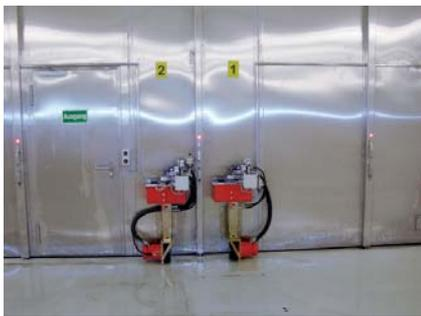
Äussere Kräfte (Luftdruck) verschlechterten den Bewegungsablauf des Schliess- und Öffnungsvorganges. Diese Zusatzkräfte bewirkten, dass bei einer Anwendung die Türverkleidung weggerissen wurde und das Tor mit grosser Wucht gegen die Tunnelwand aufschlug.
