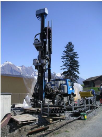
Bild: Bohrgerät im Einsatz
